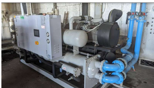
冰水機汰舊換新
